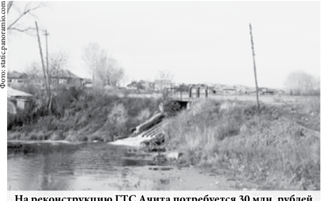
На реконструкцию ГТС Ачита потребуется 30 млн. рублей
