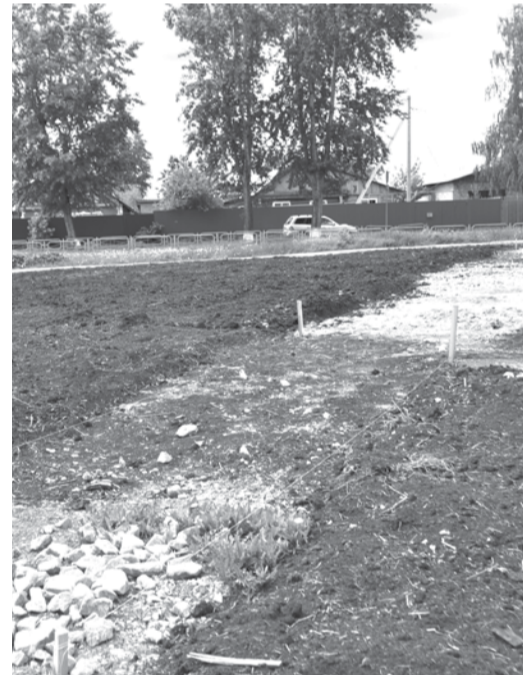
На пересечении улиц Октябрьской-Кунавина уже начались подготовительные работы.
