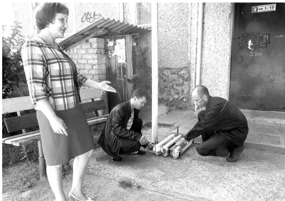
Сотрудники МУП «Городская УК» произвели замену старых радиаторов в одной из квартир многоэтажки. Наталья Щипачева старается лично контролировать выполнение работ по обращениям граждан.
