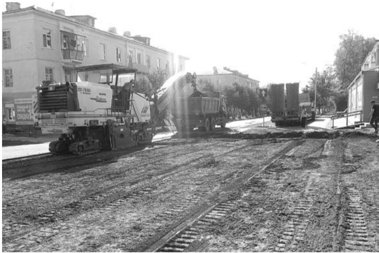
Работы по ремонту улицы Спортивной начались в 2016 году.
