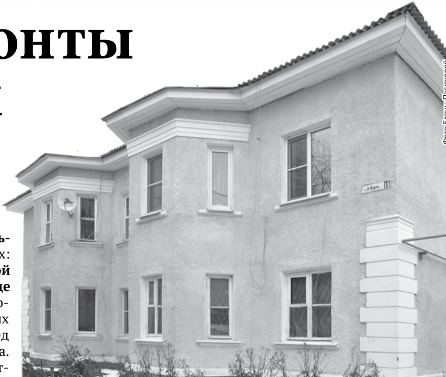
Отремонтированный по плану фасад дома № 13 на улице 8 марта.
