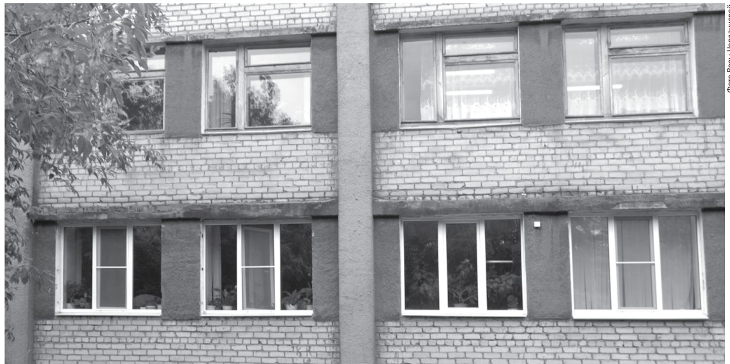
Во взрослой поликлинике идет работа по замене окон. На сегодняшний день пластиковые окна установлены на первом этаже.
