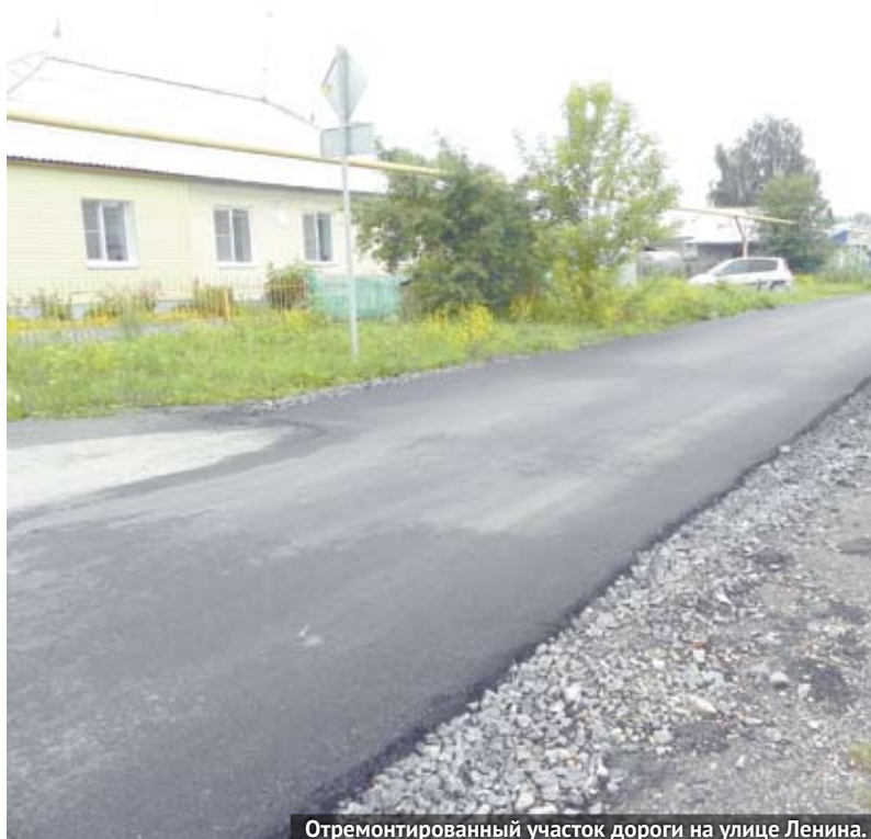
Отремонтированный участок дороги на улице Ленина.
