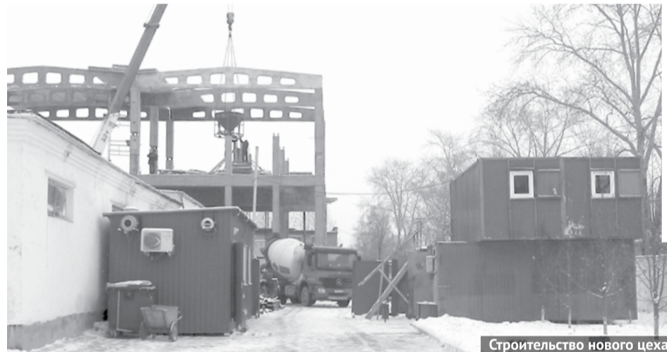
Строительство нового цеха.
