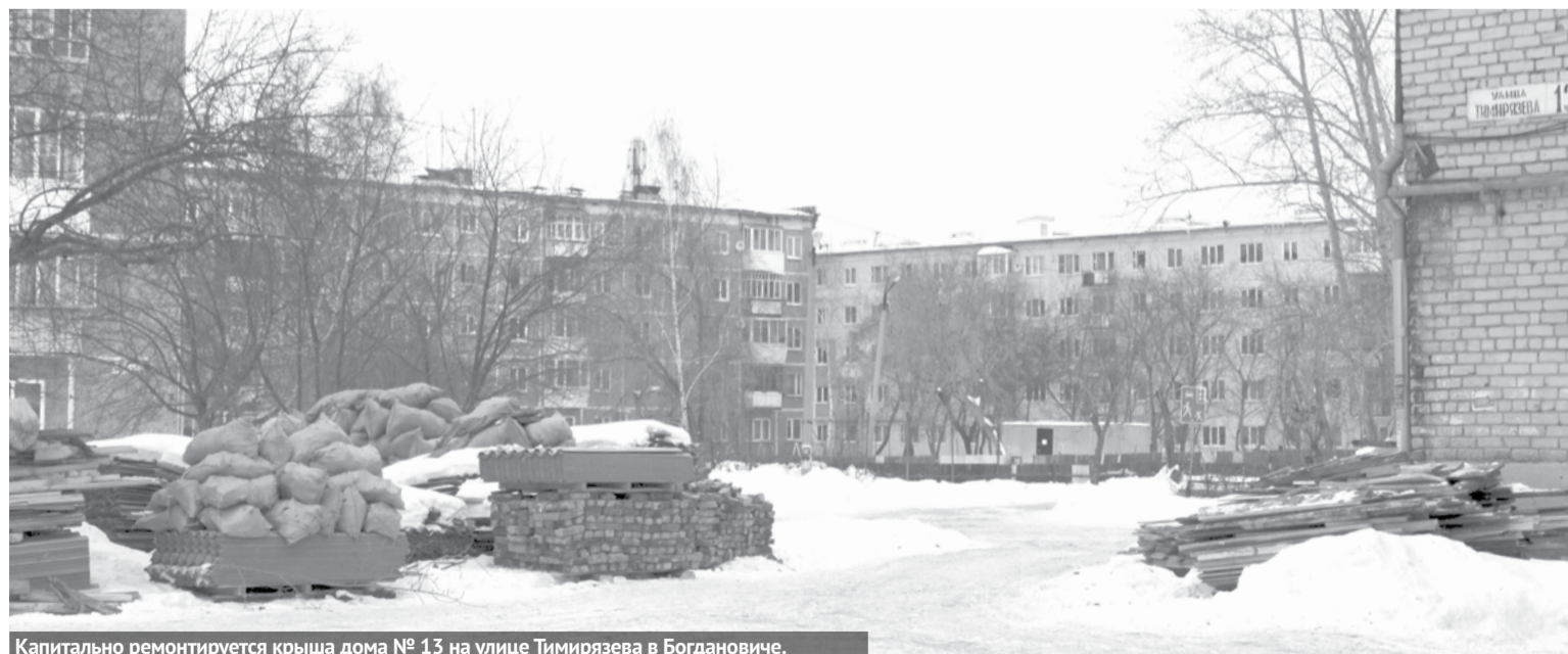
Капитально ремонтируется крыша дома № 13 на улице Тимирязева в Богдановиче.
