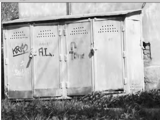
Совсем скоро газовые шкафы демонтируют - в домах старой части города появятся электроплиты
