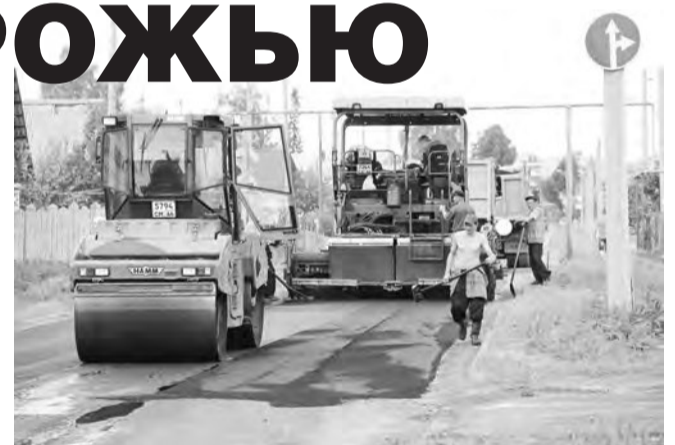
Ремонт дороги в районе Зеленого поселка
