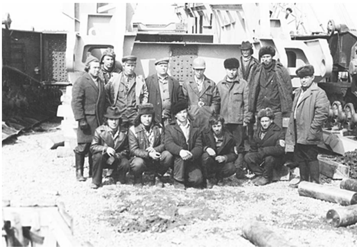
Одна из бригад «Востокметаллургмонтаж»
