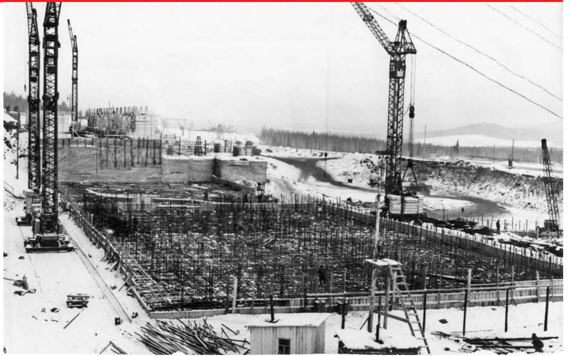
1961 год. Корпус обогащения. Вид на коробчатый фундамент
