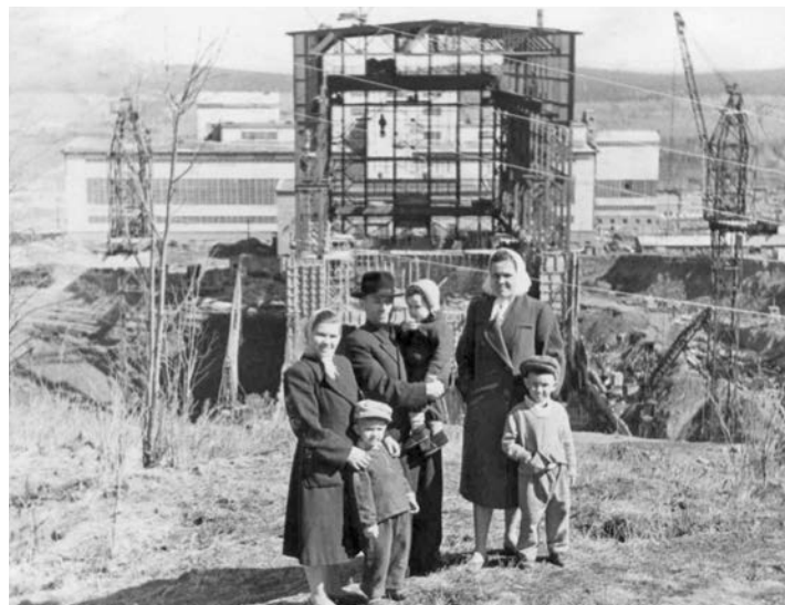
1963 год. Семья Вохмяниных на фоне строящегося корпуса крупного дробления
