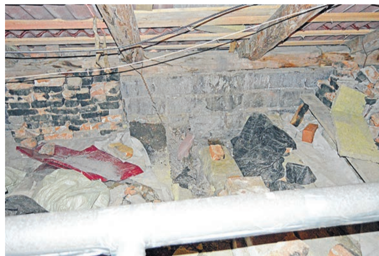
Кирпичи от разобранной вентиляционной шахты
