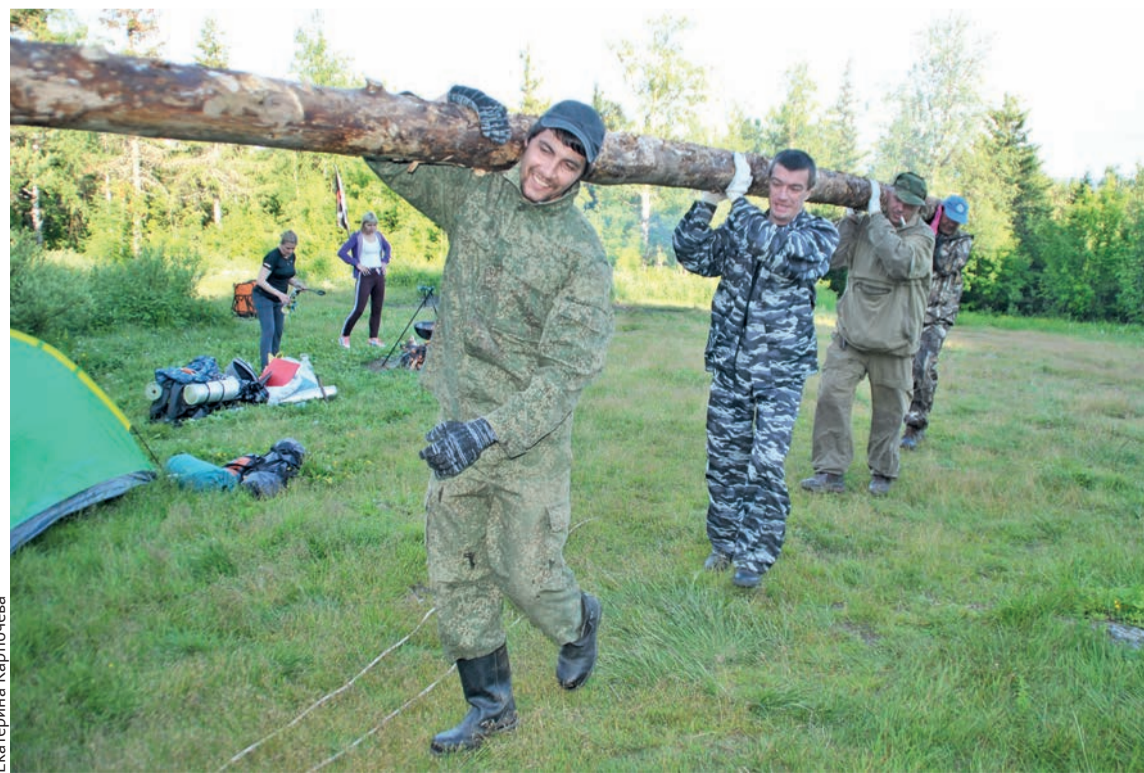
Новые опоры почти готовы!
