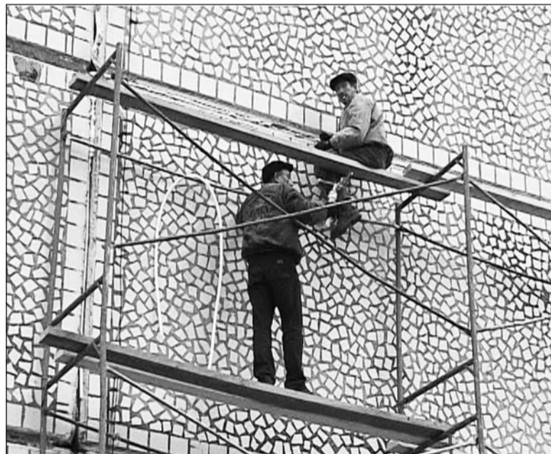
До третьего этажа работают на лесах
