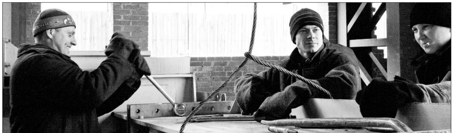
Последний электромостовой кран готовится к подъёму
