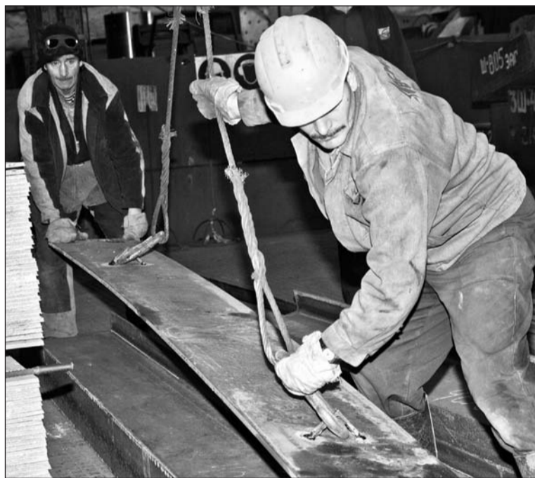
Рабочие цеха № 19 меняют рельсовые пути для манипулятора
