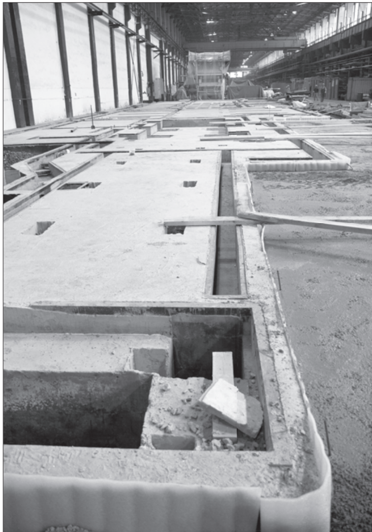
70-метровый фундамент для линии правки плит
