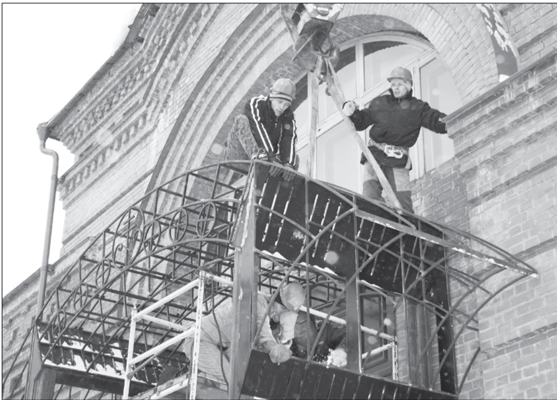
Специалисты цеха № 50 и в строительство храма свой труд вложили
