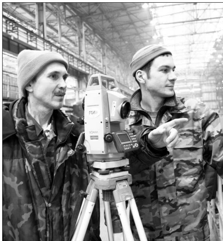
Инженеры-геодезисты Андрей Шувалов и Сергей Загарей производят разметку фундамента
