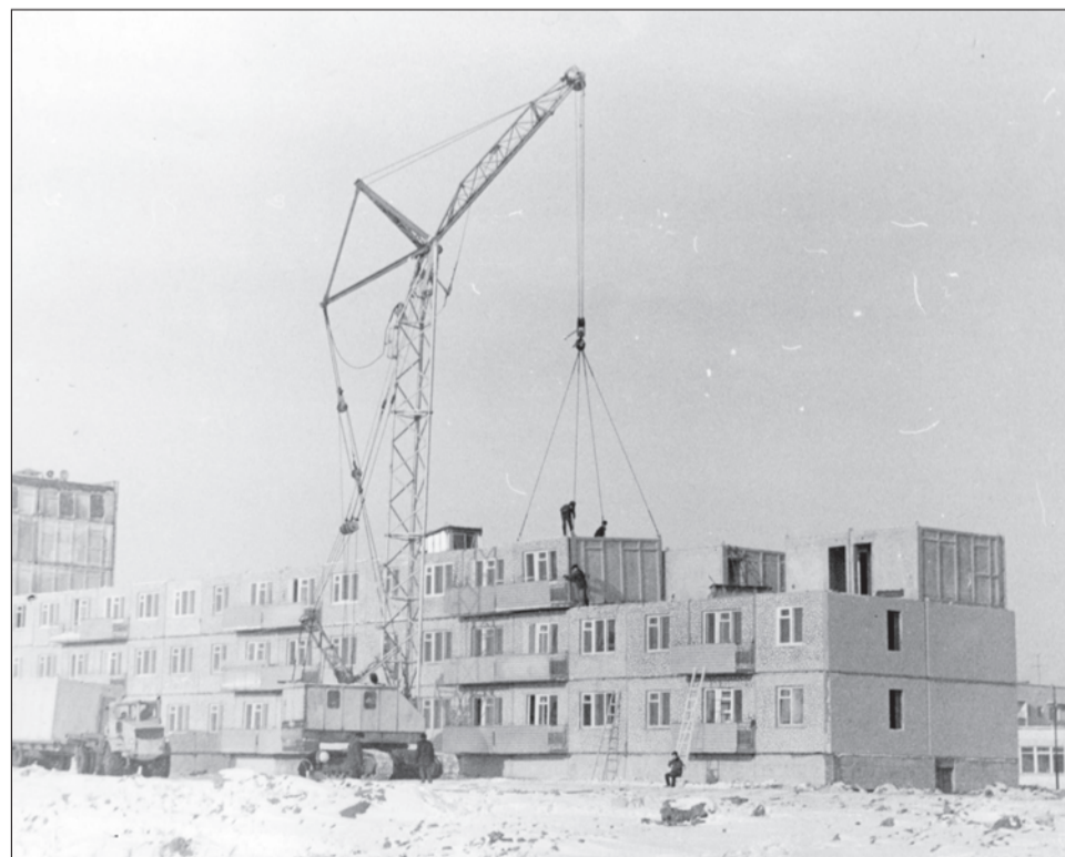
Верхняя Салда – второй после Краснодара город, где использовалось объёмное блочное домостроение
