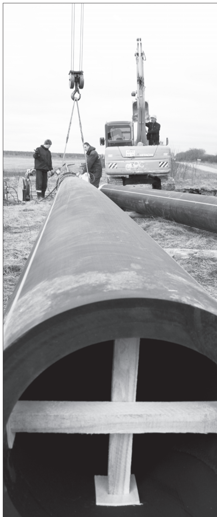
Именно такие трубы планируют прокладывать по улице Парковой
