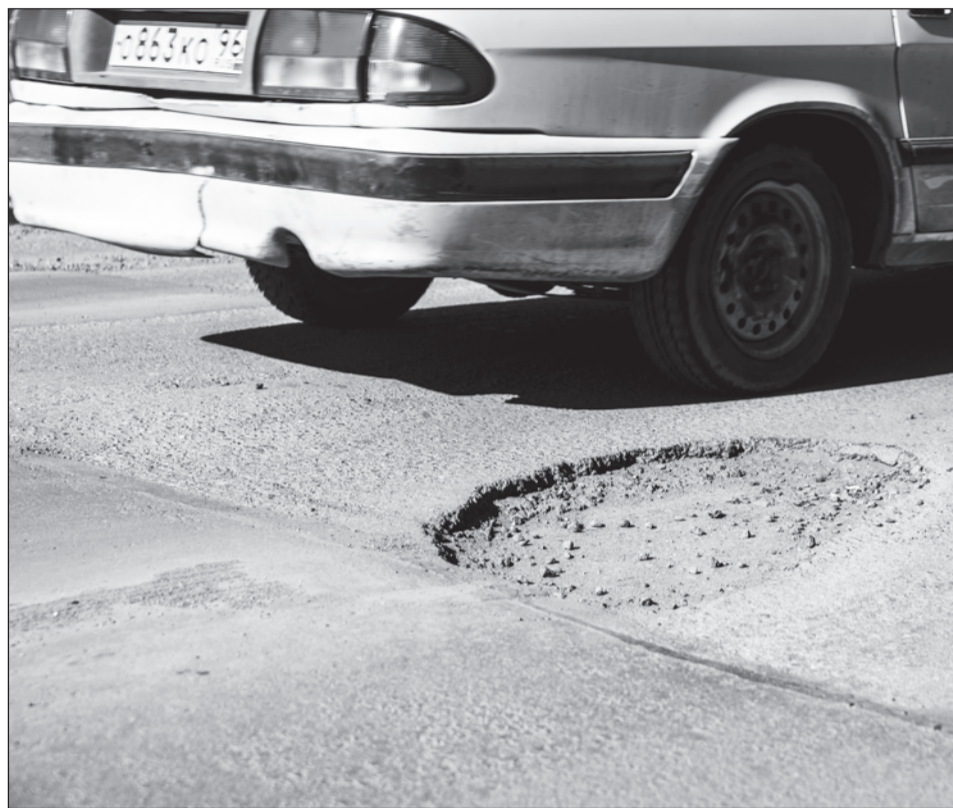
Начало участка, который отремонтировали дорожные рабочие по улице Воронова
