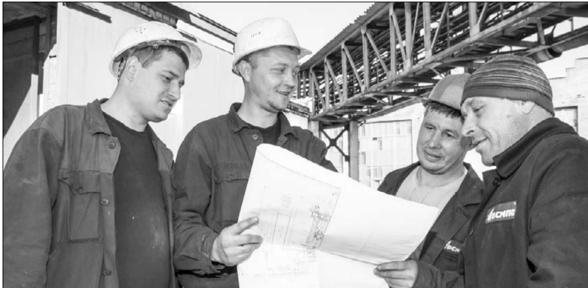
Монтажники цеха № 50 обсуждают фронт работ
