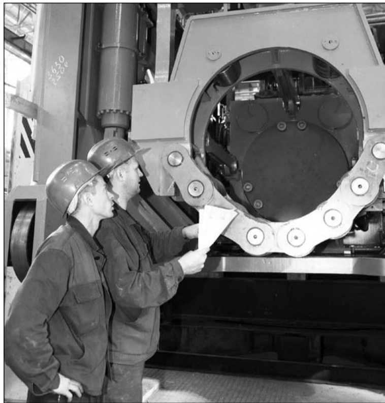
Стотонная Glama установлена временно
