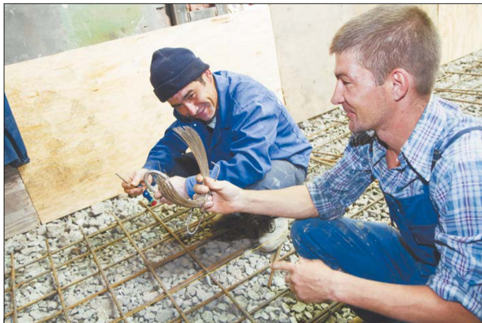
Двойное армирование – основа для топпингового напольного покрытия
