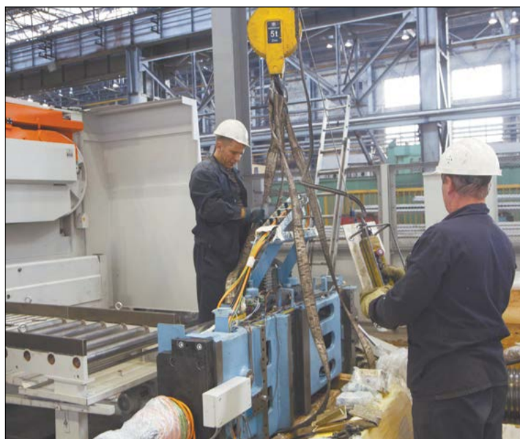
Бригада цеха № 50 заканчивает монтаж ещё одного нового немецкого станка
