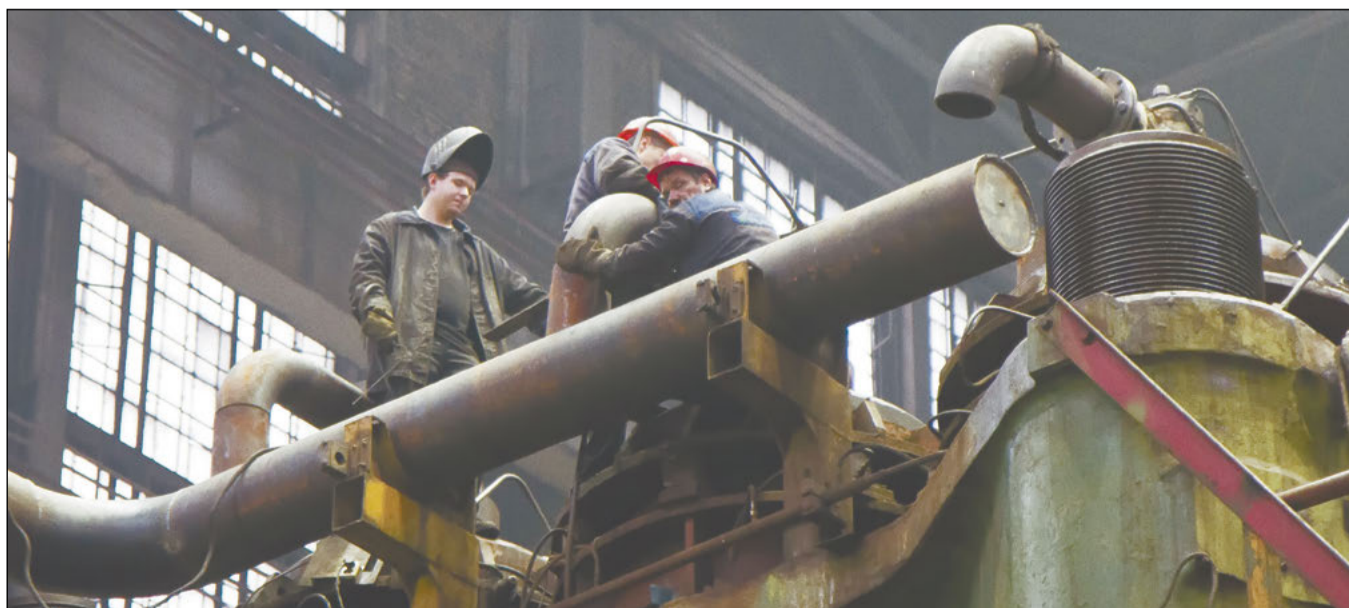
Пока новая печь проходит пусконаладку, на прессе-106 продолжается капитальный ремонт
