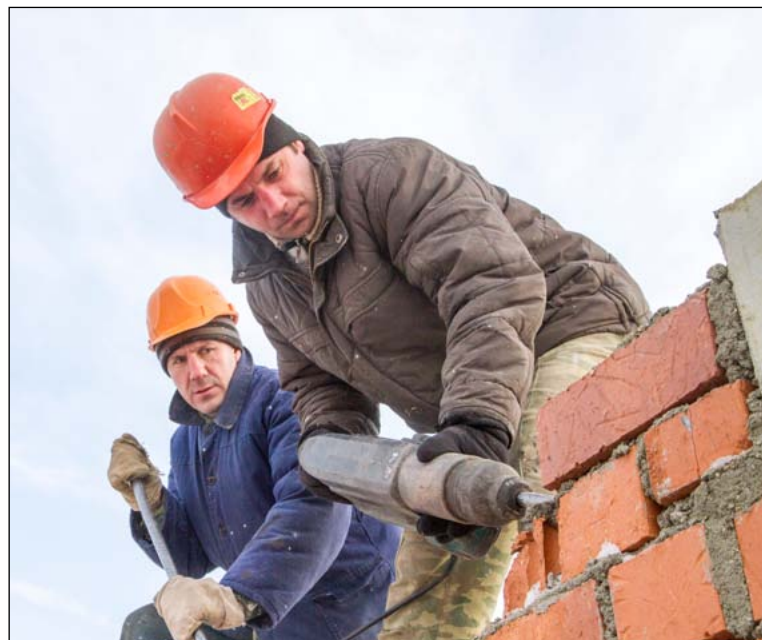
Александр Агинских и Виталий Ошуев удаляют дефектную кирпичную стену
