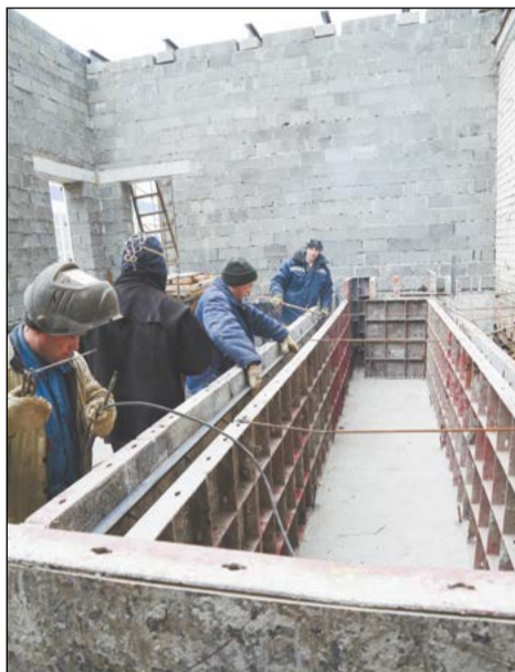
Опалубка – важный этап в строительстве фундамента
