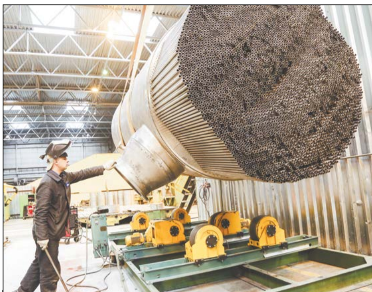
В основе теплообменника – 3 800 титановых труб
