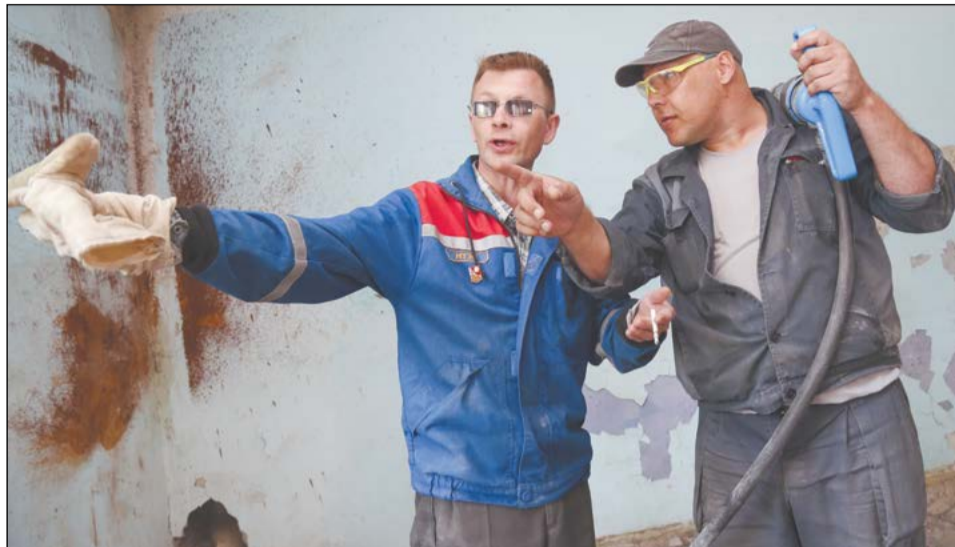
Штукатуры Вячеслав Тархов и Алексей Чикеев придают стенам старого здания современный вид
