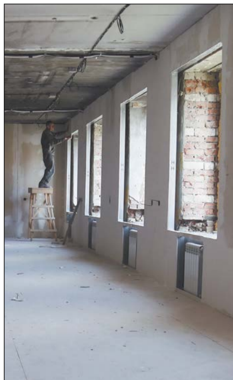
Идёт монтаж системы кондиционирования
