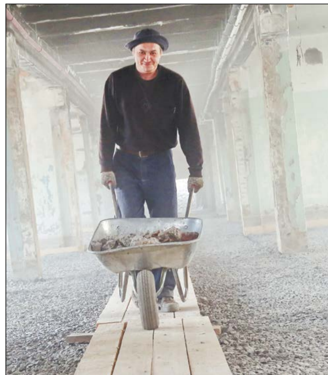
Штукатур Алексей Сухарев и маленькая тележка щебня вдобавок к 250 кубам, утрамбованным на первом этаже
