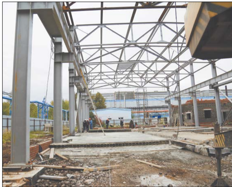
Основа здания новой компрессорной станции растёт буквально на глазах
