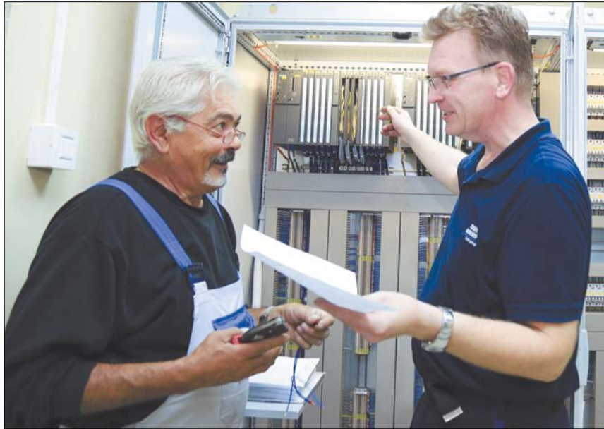
Немецкие специалисты оценивают работу, выполненную электромонтёрами цеха № 6
