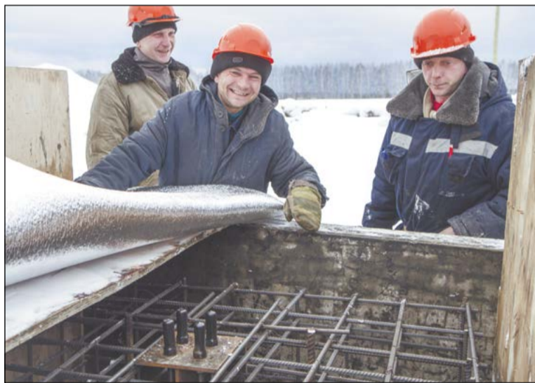
Опалубка и обрешётка готовы к заливке бетона
