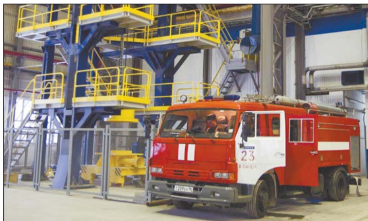
На участке новых гарнисажных печей дежурит боевой расчёт предприятия «ВСМПО-Пожарная охрана»
