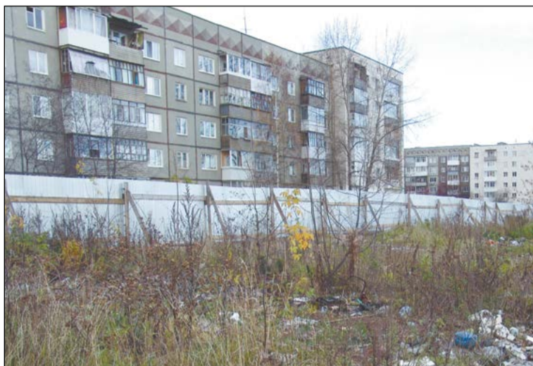
Там, где рос бурьян и размещались гаражи-«нелегалы», начинается строительство жилого комплекса
