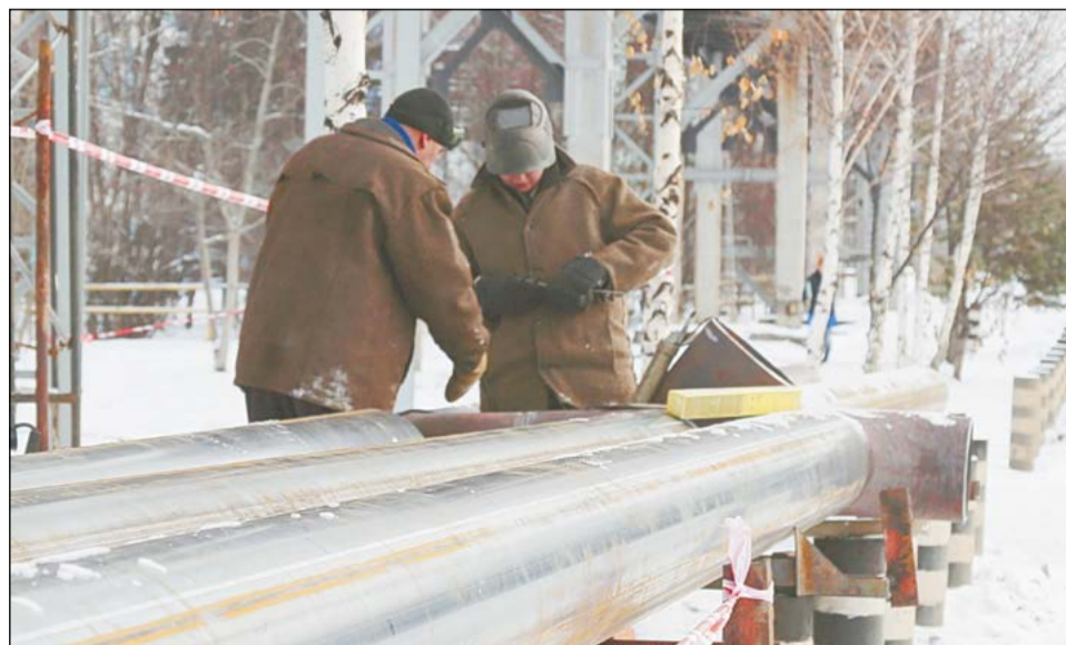
Монтаж трубопровода в самом разгаре
