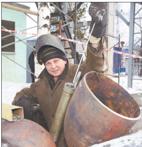
Электросварщик Александр Морозов соединяет трубы
