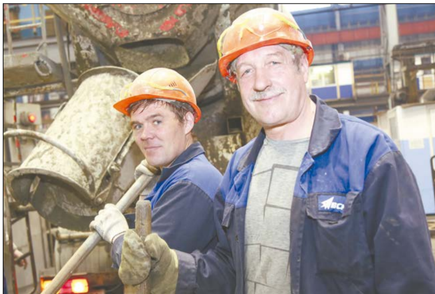
Андрей Адамов и Михаил Боровиков принимают бетонный раствор
