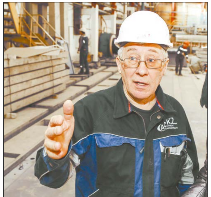
Монтаж электрической части линии курирует Евгений Лузгин
