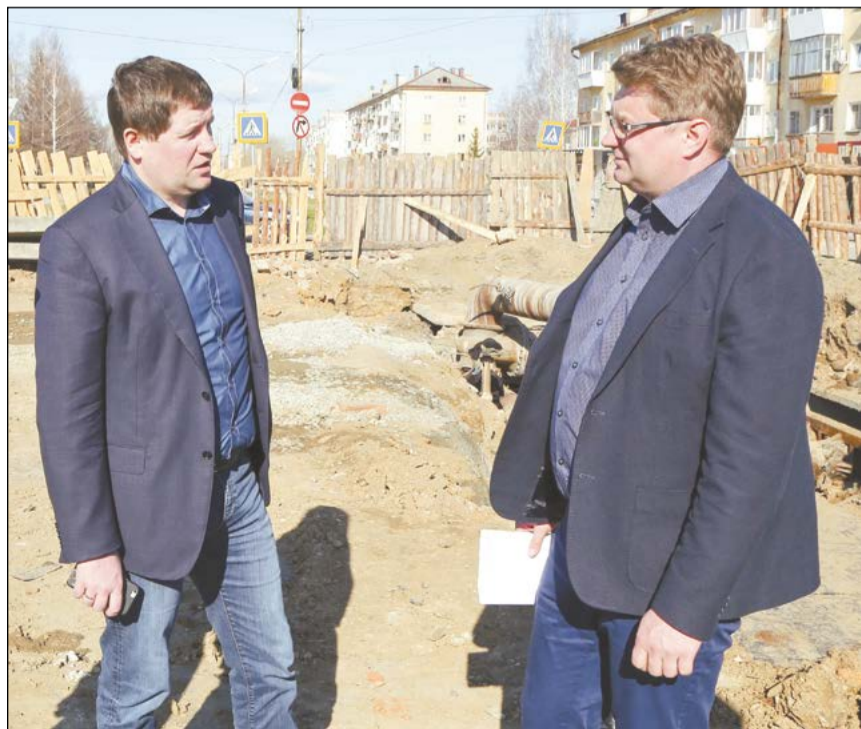
Константин Ильичёв рассказал депутату Государственной Думы о ходе работ по спрямлению дороги по улице Энгельса
