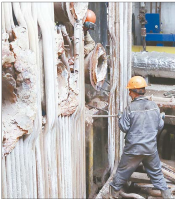
Подрядчики демонтируют котёл
