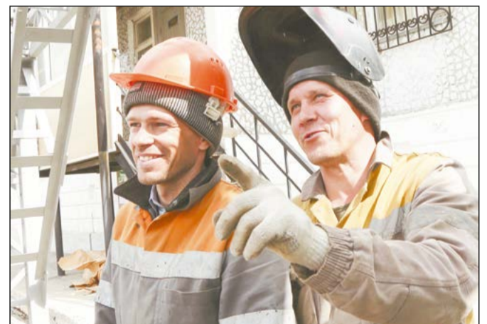
Монтажники прикидывают, сколько сварных швов предстоит выполнить при сборке навеса
