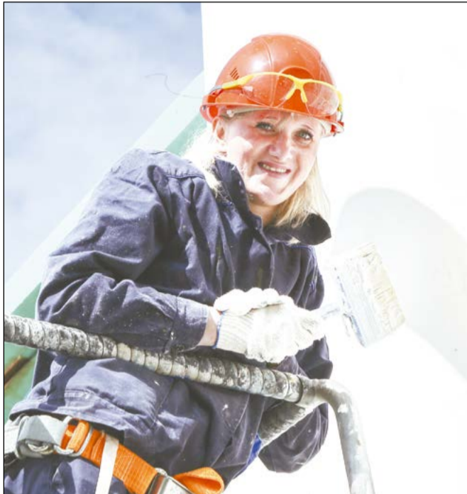
Десятки раз взмывают маляры на подъёмнике, чтобы слой за слоем восстановить фасад проходной
