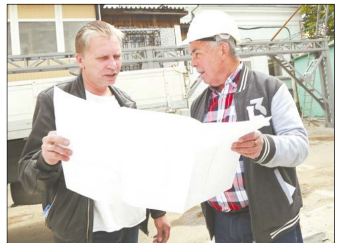
Во время сборки металлоконструкций идёт обсуждение операций электромонтажа
