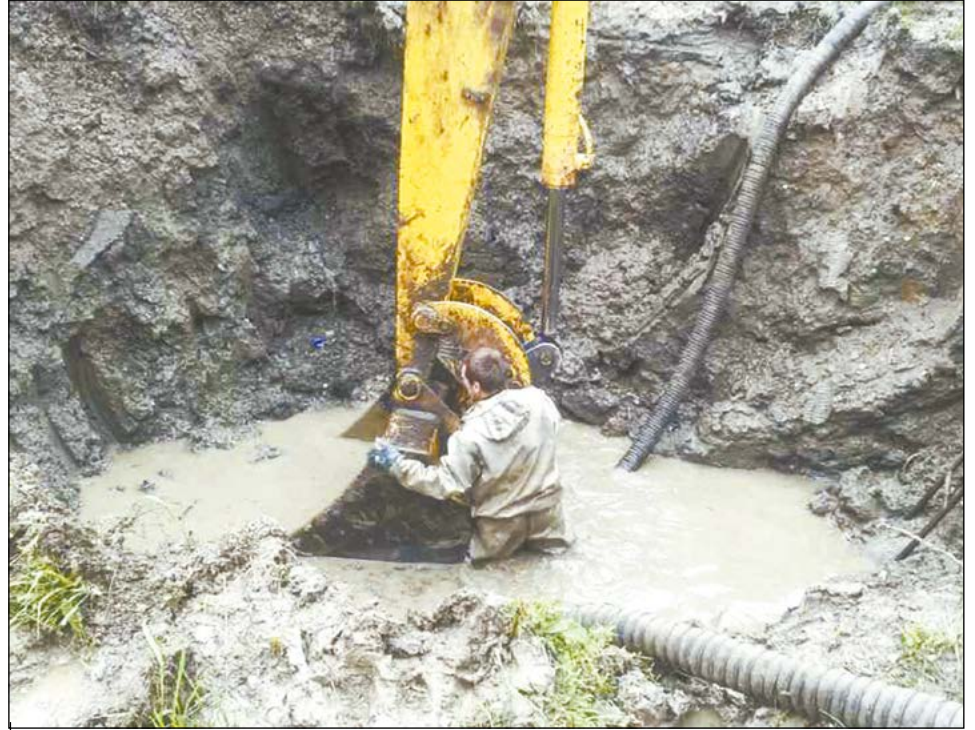
Устранение аварии на улице Воронова, 7 июля 2017 года
