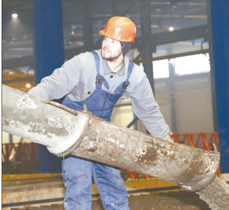
Под управлением бетонщика Николая Малкова бетон ложится как надо
