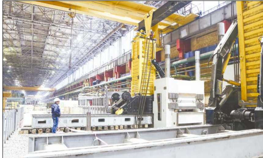
Для сборки новой правильной машины понадобился мощный гидравлический пресс
