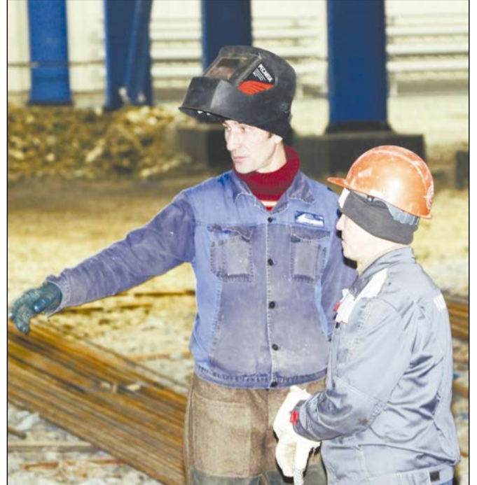
Сварщик Эдуард Ведерников и бетонщик Алексей Хлебников гарантируют качество фундамента
