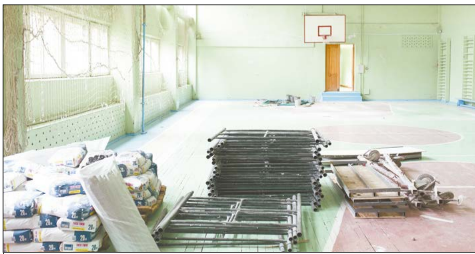
Ремонт в спортзале продолжается
