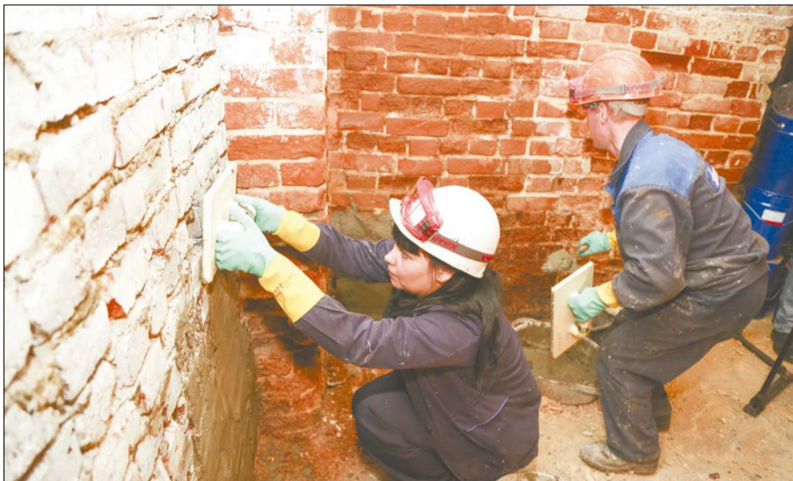
На штукатурку стен ушёл куб раствора
