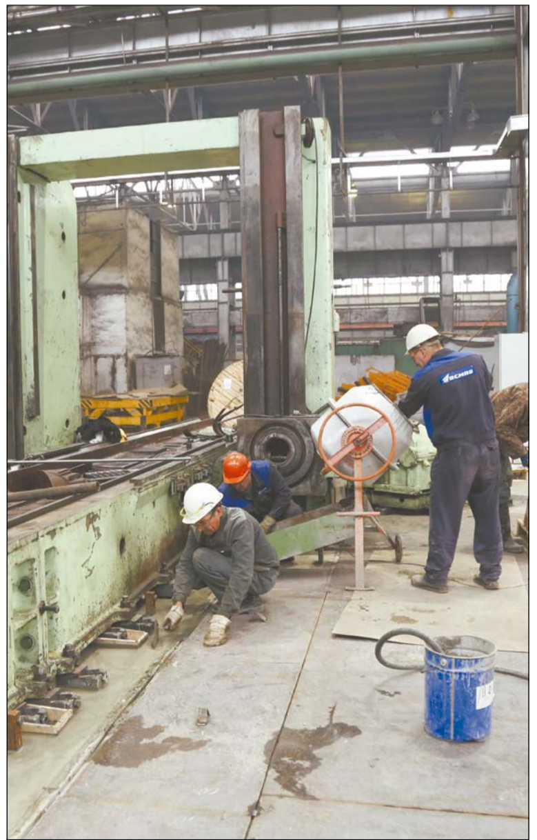
Сотрудники УКСа заканчивают монтаж станины
