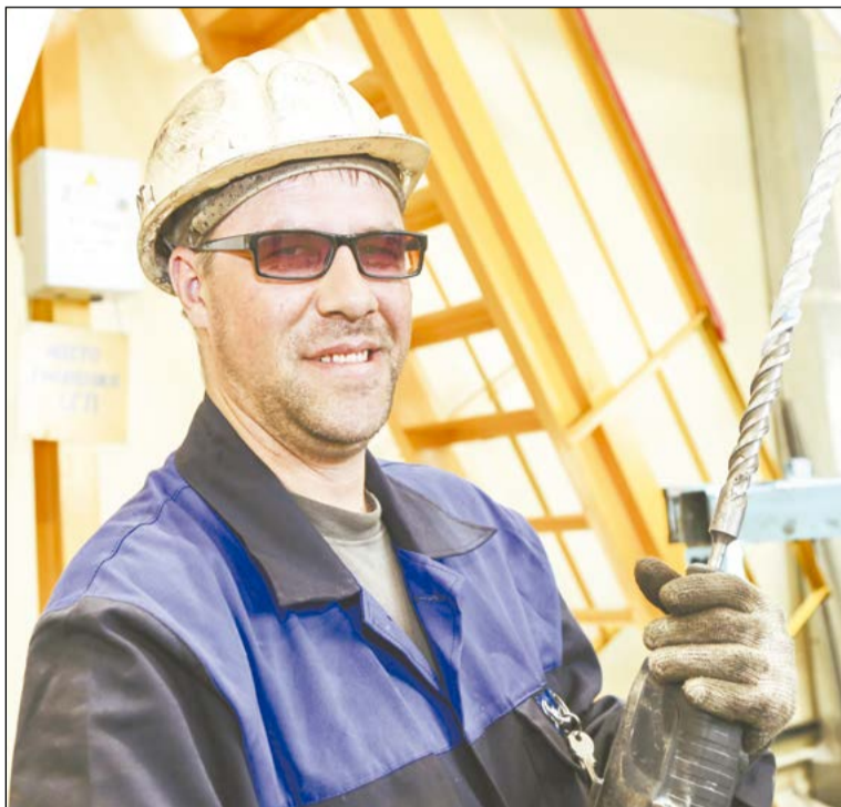
Перфоратор для Виктора Михайловского незаменим, когда необходимо высверлить отверстия под анкерные болты
