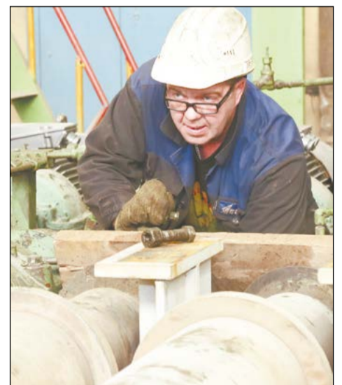
Слесарь-ремонтник Сергей Верзаков монтирует центрирующее устройство
