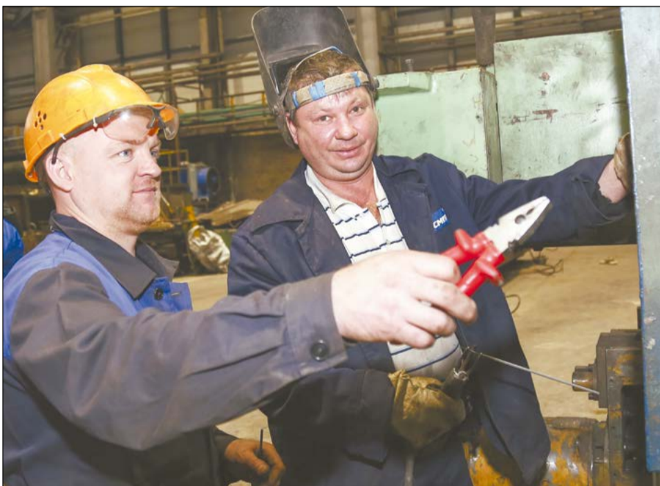
Виктор Воробьёв и Роман Ухов монтируют дополнительное распределительное устройство
