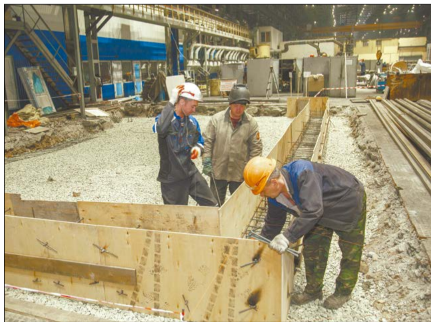
Специалисты фирмы «УралСтройКомплекс» выставляют опалубку для будущего фундамента
