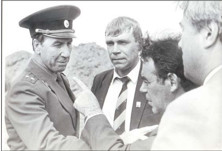
Военные строители сдают здание ЧЛЗ
