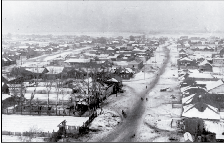
Вид с колокольни церкви Иоанна Богослова
