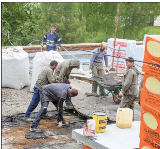
Будет и у Дома книги новая кровля!
