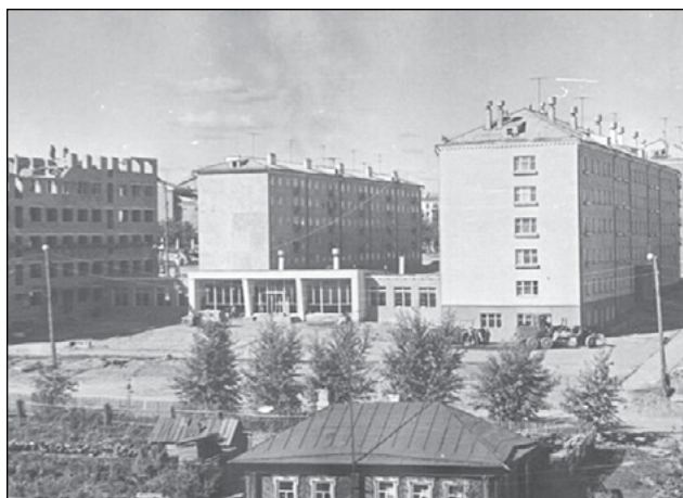
Кафе «Юность», общежитие № 6 ещё строится. 1970 год
